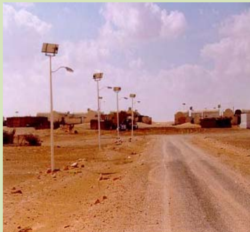
Eclaire public par voie solaire de 71000 poteaux financé par le gouvernement (2012-2013)
